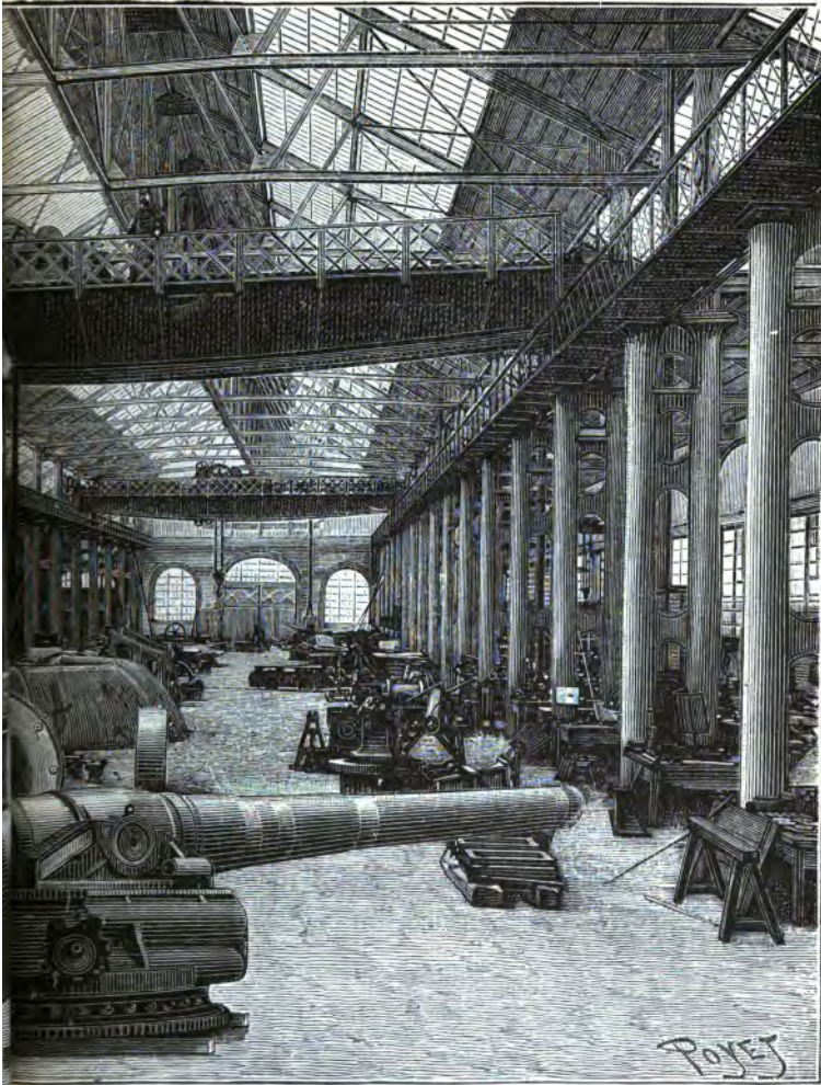
Atelier de montage avec pont roulant.
